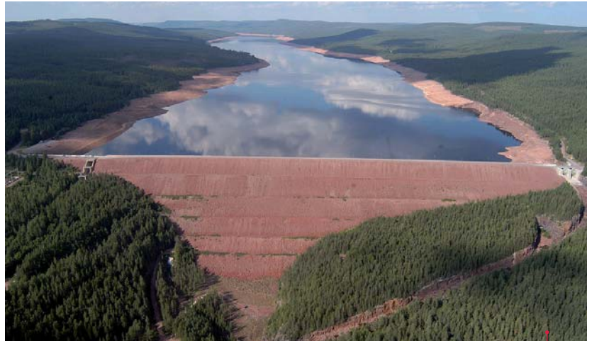
Le barrage de Trångslet en Suède (photo ICOLD)
