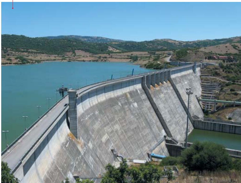
Le barrage de Cantoniera, sur le Tirso, essentiel pour l'alimentation en eau de la Sardaigne (photo ICOLD-CIGB)
