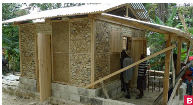
Figure 3. Chantiers du programme de reconstruction soutenu par Misereor : (a) ossature bois avec remplissage en clissage et briques en terre crue ; (b) ossature bois avec remplissage en maçonnerie de pierres avec mortier terre. © A. Caimi
